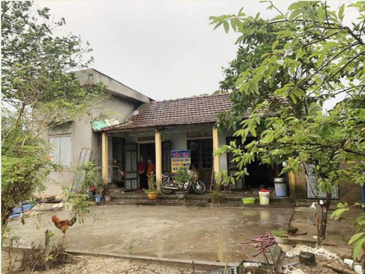
The storm-resilient house of Trương Thị Tình in Mai Xá village, Gio Linh commune, Quảng Trị province
